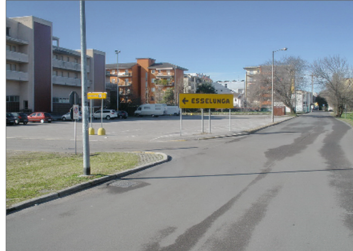
08 Viale Sicilia da est dopo rotonda (ante realizzazione)
